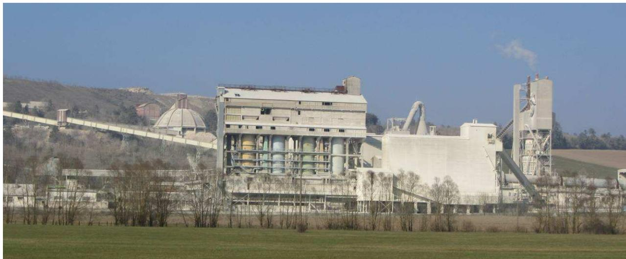
La chaux est obtenue par calcination d'un calcaire à une température supérieure à 900°C.
